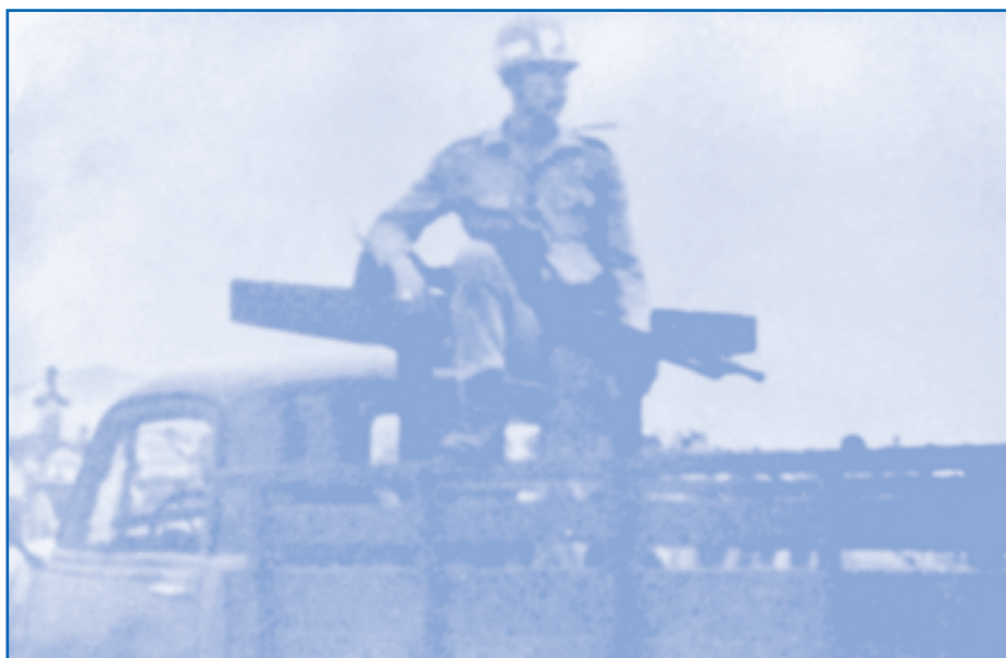
Policial sobre o caminhão, momentos de abrir fogo contra os trabalhadores
